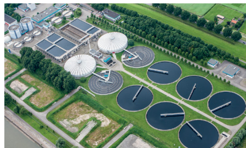
Stație de epurare a apelor uzate
